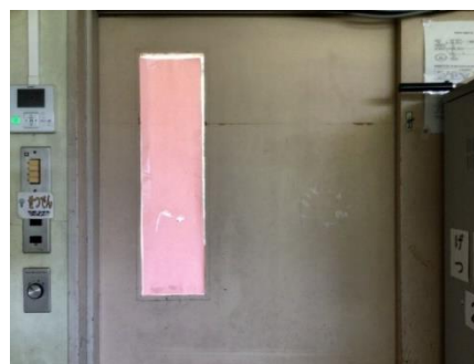
教室のスリット窓に目隠しをしています
